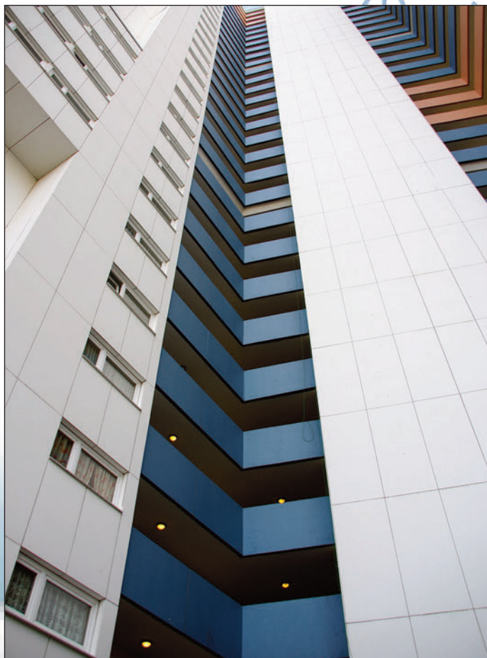
Das höchste Wohnhaus Deutschlands, das Ideal-Hochhaus in der Fritz-Erler-Straße ist Schauplatz des Tower-Runs.
